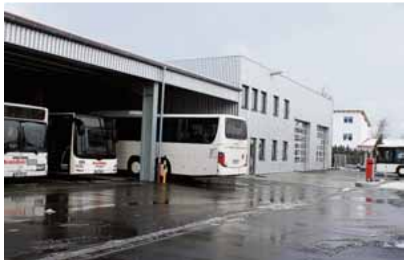
Einen neuen Betriebshof hat die Firma Brandner im Ottobeurer Gewerbegebiet errichtet. Foto: Brigitte Unglert-Meyer
