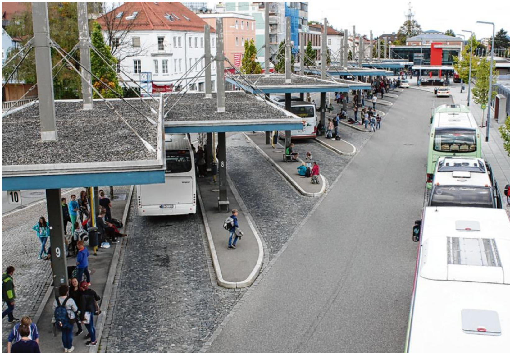
Der Zentrale Omnibusbahnhof (ZOB) in Memmingen spielt auch bei einem neuen Verkehrskonzept eine wichtige Rolle.
