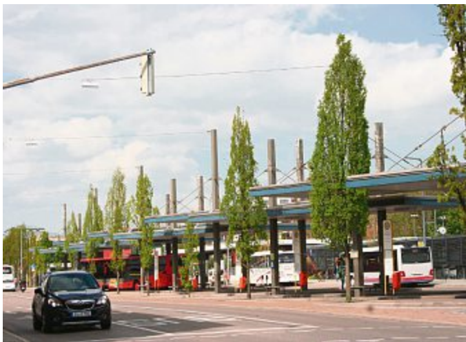
Der Zentrale Omnibus Bahnhof (ZOB) in der Bahnhofstraße ist der Hauptknotenpunkt beim Stadtbuskonzept.
